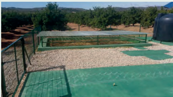
Fotos 6 y 7. Imágenes del sistema Phytobac para gestión de efluentes de lavado de equipos de aplicación de fitosanitarios en una explotación cítrica de E. Martinavarro en Llíria (Valencia).
