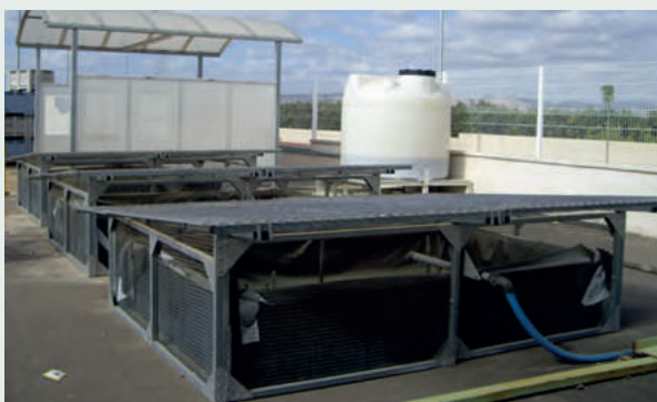
Fotos 4 y 5. Sistema Helioseca para gestión de efluentes de lavado de equipos de aplicación de fitosanitarios en la Cooperativa CANSO de l'Alcudia (Valencia) .
