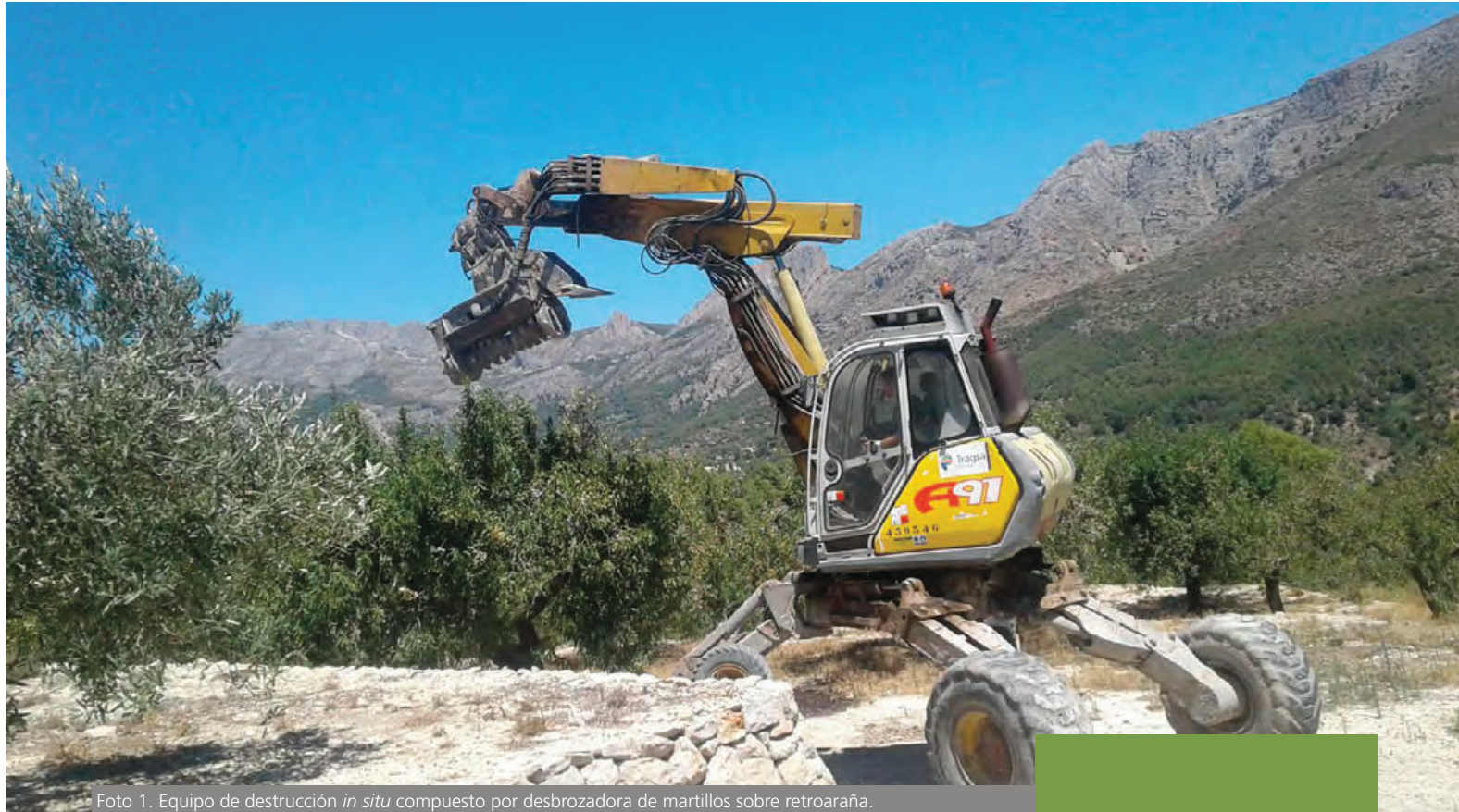
Foto 1. Equipo de destrucción in situ compuesto por desbrozadora de martillos sobre retroaraña.
